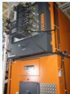
生チップ焚き温水機(900kw)
