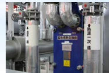
施設内配管および熱交換器
