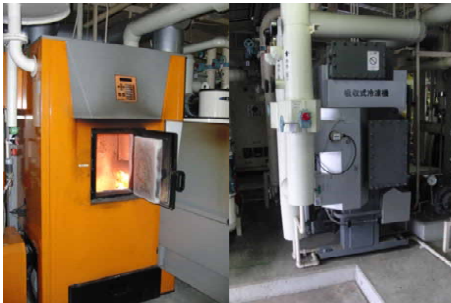
(ペレットボイラー 吸収式冷凍機)
