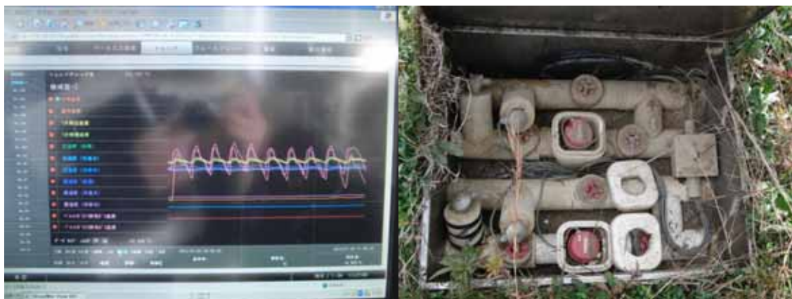
(管理画面 使用量計測機器(温度計・流量計))
