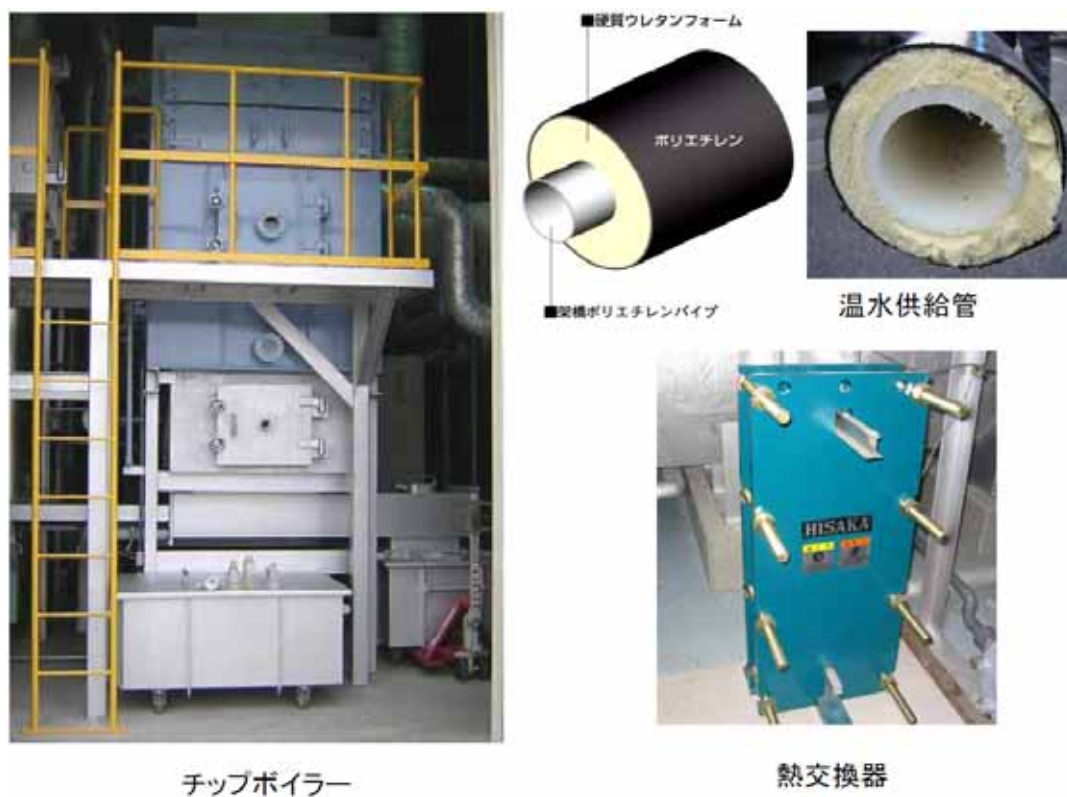
図 3-44 高島市熱供給施設のシステム構成機器
