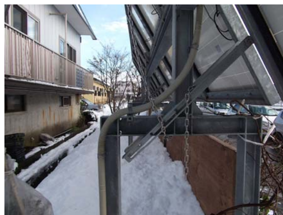
角度可変太陽光発電パネル架台
