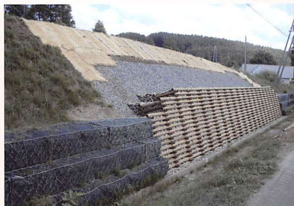
下川町:土留工
