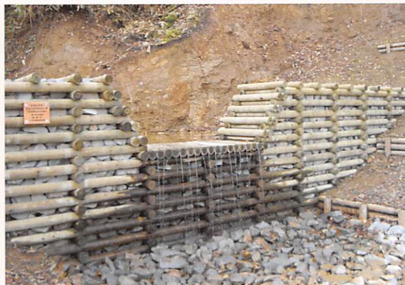
中川町:床固工
