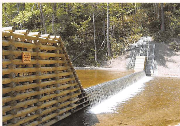
佐呂間町:床固工
