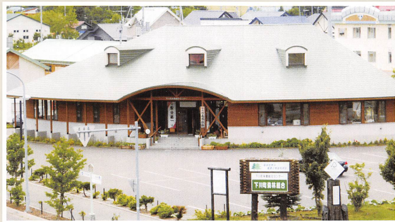
下川町森林組合事務所棟
