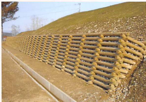
下川町:土留工
