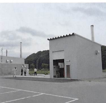
ウェルネスプラザの南側にあるボイラ
