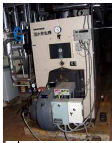
▲ A 重油ボイラ 設置後 12 年以上経過し、更新時期に来ている。
