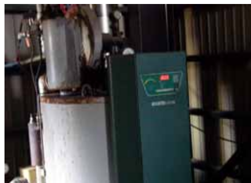
▲ 現在使用中の A 重油ボイラ (出力は最大 215,600kcal)
