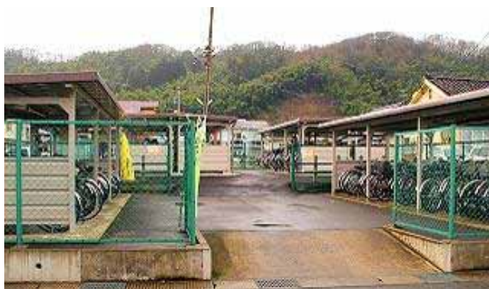
西富山駅自転車駐車場
