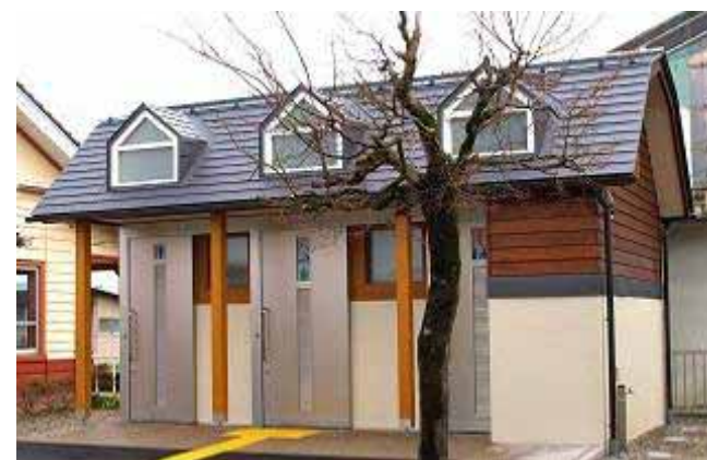
JR敷地を借用し水洗トイレを整備(市公衆トイレ)
