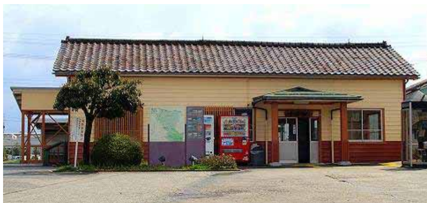
千里駅: 建設当時の塗装でリニューアル
